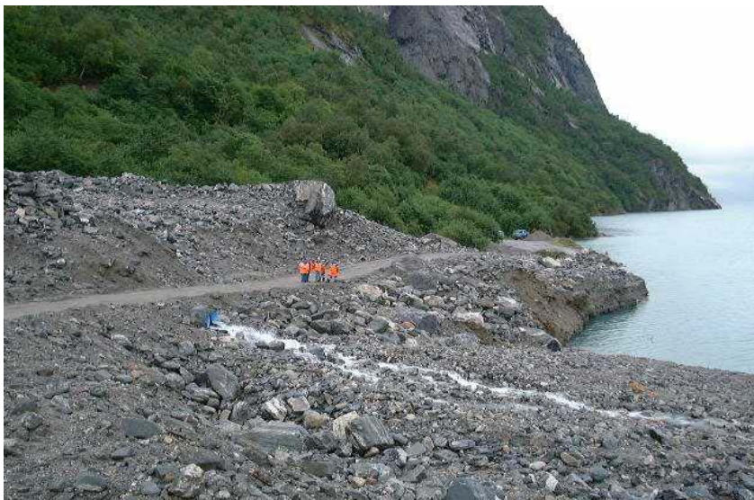
Bildet viser flomskred forårsaket av intens nedbør på Møre. Eikesdalen (2003).
